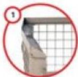
Il telaio superiore o i montanti angolari sono deformati.
